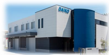
[広島営業所 外観写真]
